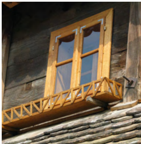
Obnovljeni prozor s ograđenom klupicom za cvijeće
