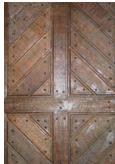
Detalj tradicijskih vrata od hrastovine s kovanim čavlima. Daščice su postavljene dijagonalno na ukrutni križ
