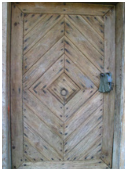
Tradicijska vrata od hrastovine s kovanim čavlima. Daščice postavljene dijagonalno iz kvadratičnog ishodišta.
